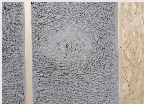
Industrieel aangebrachte cellulose in een houtskeletbouw element
