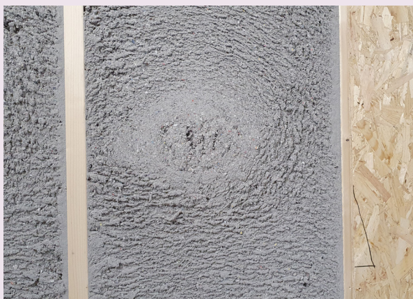
Ingeblazen cellulose
